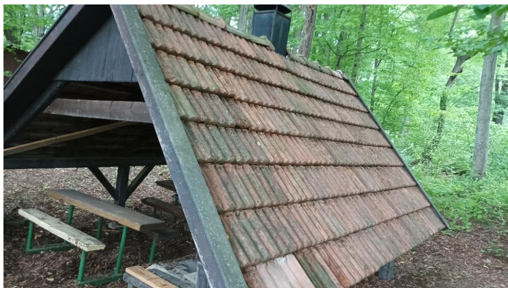
V roce 2022 bylo již vše svépomocí opraveno.
